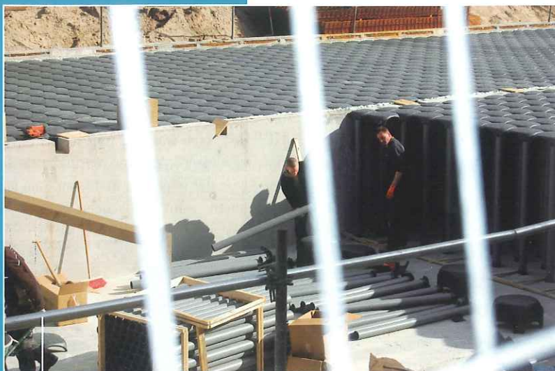
Arbeiders zijn bezig met de aanleg van het Watershell-systeem.
