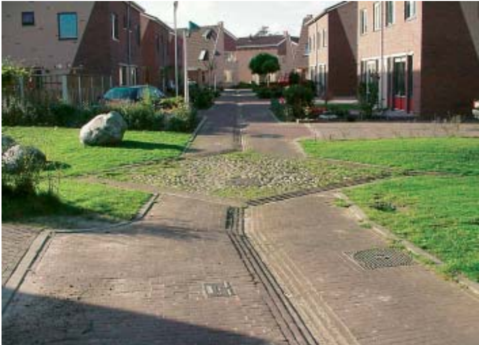
Figuur 9 De voorde zorgt voor de verdeling van het regenwater naar de wadi
