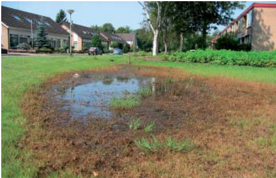
Figuur 52 Het water in deze wadi blijft (te) lang staan na een regenbui
