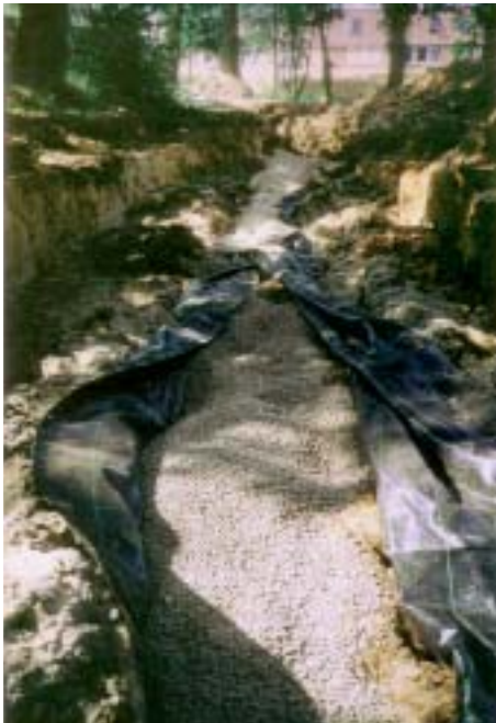
Figuur 12 Boven: aanleg rode wadi in natte omstandigheden
