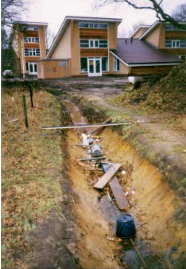
Figuur 23 Tijdelijke greppel tijdens de bouw
