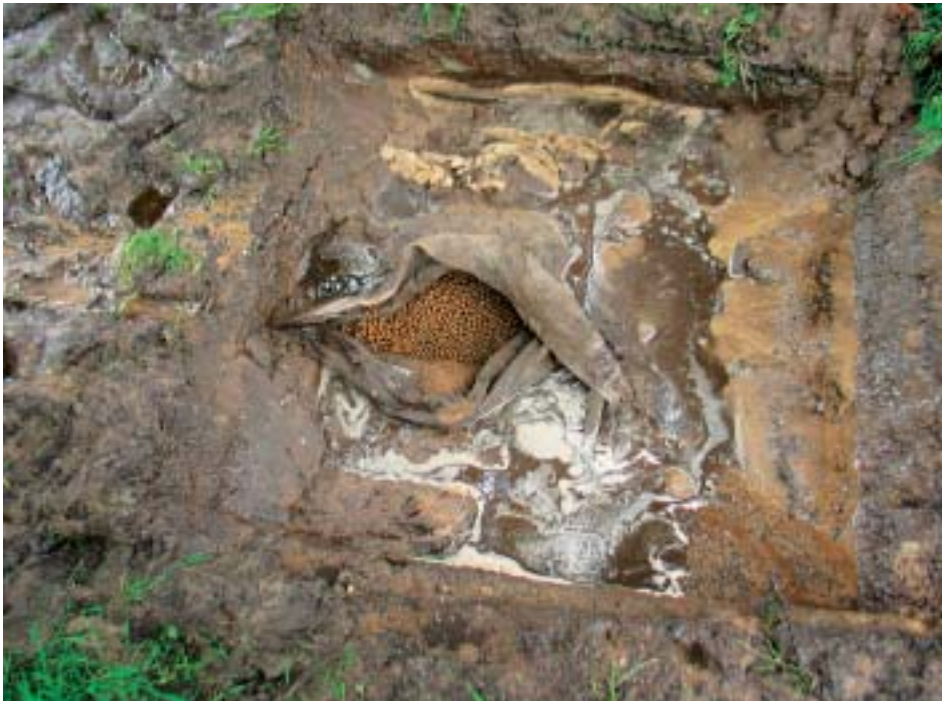
Figuur 37 Opgraving van het vlies in de groene wadi
