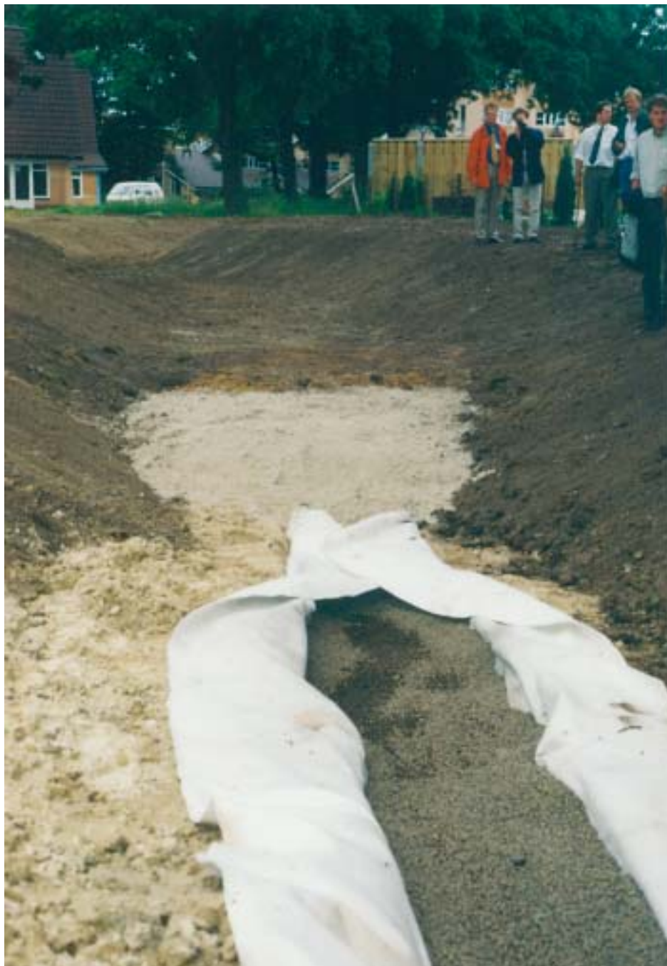
Figuur 46 Aanleg van de groene wadi (nb: dezelfde locatie als figuur 37)
