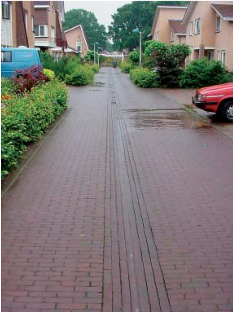
Figuur 3 Ruwenbos kent smalle woonstraten met bovengrondse regenwaterafvoer
