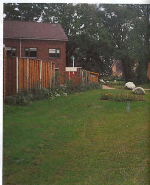
Wadi in Enschedese wijk Ruwenbos zonder begroeiing (links, met links de toplaag en rechts de zogenaamde 'slokop' voor waterafvoer naar de berging) en met grasbegroeiing.
