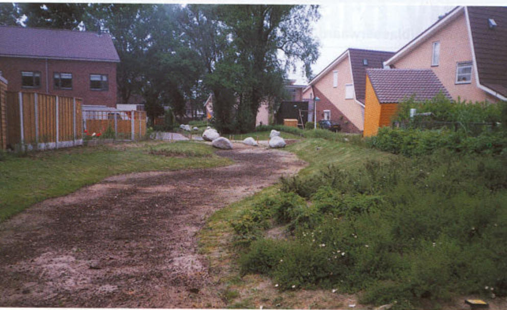
Wadi in Enschedese wijk Ruwenbos zonder begroeiing (links, met links de toplaag en rechts de zogenaamde 'slokop' voor waterafvoer naar de berging) en met grasbegroeiing.
