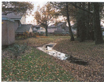
Bladval kan de doorlatendheid van de grasmat van de wadi verminderen.
