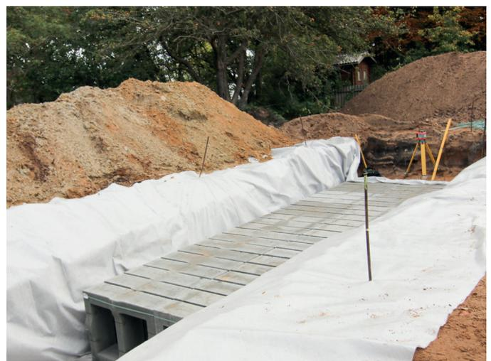
beDrain® Versickerungsblöcke mit Filtervlies Secutex 151 GRK 3 C, 150g/m<sup>2</sup> ummantelt
